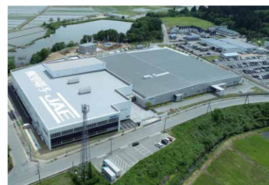
山形航空電子 第2工場(新棟左側)
