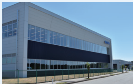
山形航空電子 第二工場B棟(2023年5月竣工)
