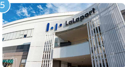
5 ららぽーと立川立飛 立川エリア最大級の商業施設
